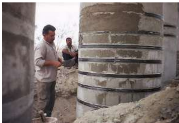
شکل ۶: استفاده از لمینیت الیاف کربن در فرآیند مقاومسازی پایه‌های پل‌های راه‌آهن محور بافق-بندرعباس
