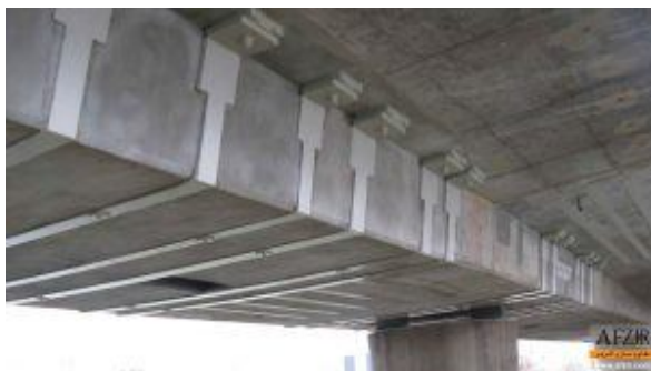
تقویت دال بتنی با ورق فولادی
