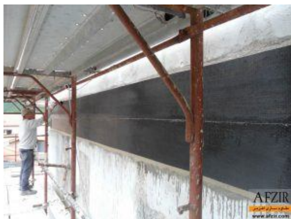
ترمیم دیوار بتنی با الیاف CFRP
