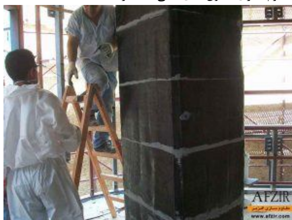
ترمیم ستون بتنی با الیاف FRP
