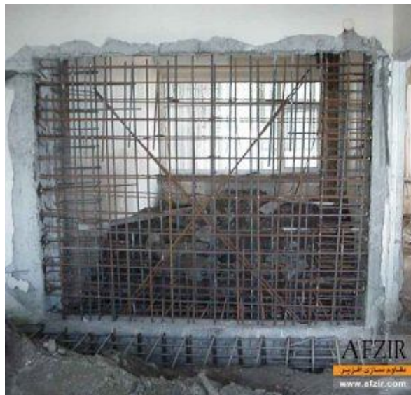
مقاوم سازی ساختمان با افزودن دیوار برشی بتنی
