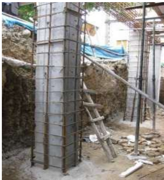
شکل ۱: اجرای روکش ستون بتن مسلح
