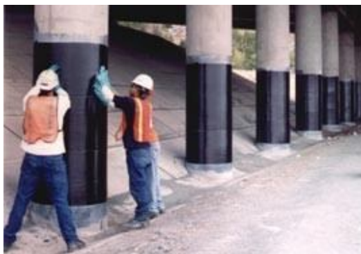
شکل ۳: اجرای روکش تیر و ستون بتنی با مصالح FRP
