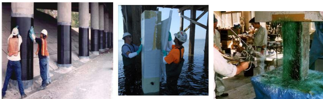
شکل (۱) مقاوم سازی ستون های بتنی با FRP: اسپری - محفظه ای - پوششی
