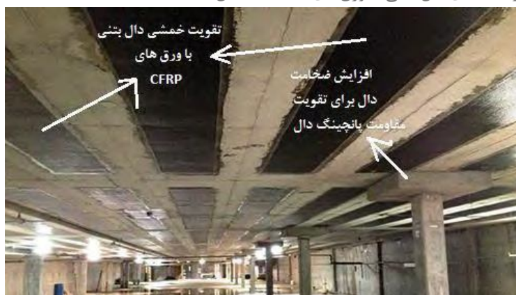
شکل ۳: قسمت‌های تقویت‌شده‌ی دال بتنی با ورق‌های CFRP
