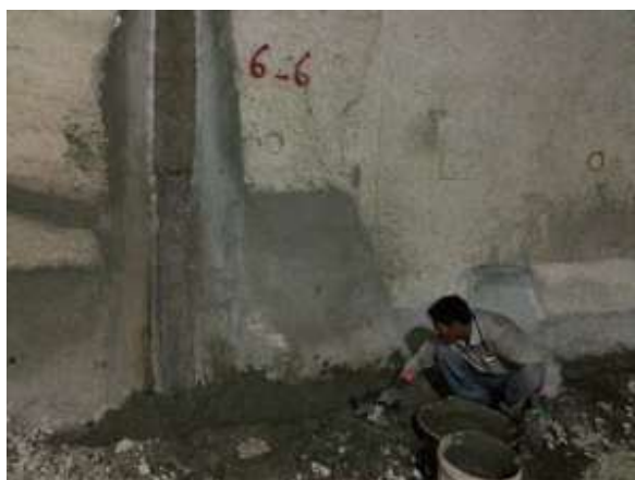
شکل ۱۲: پروژه آببندی سطوح و درزهای لاینینگ تونل‌های خط ۶ متروی تهران بروش آببندی منفی
