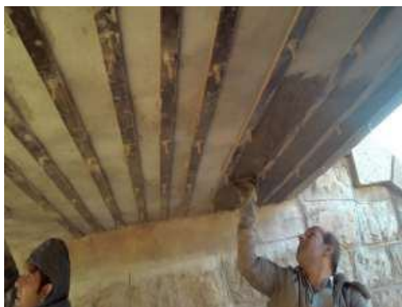
شکل ۸: مقاوم‌سازی دال پل‌های راه‌آهن محور قم به کاشان با استفاده از تسمه فلزی
