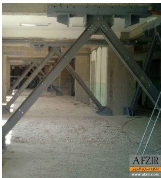
مقاوم سازی ساختمان با افزودن مهاربند فولادی
