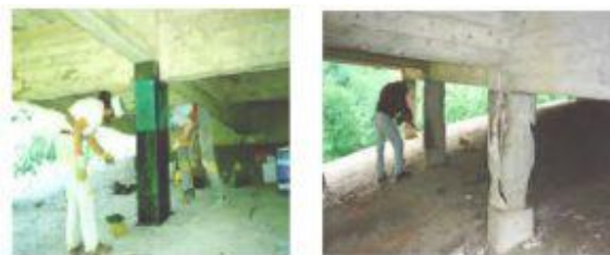
شکل شماره چهار: سازه‌های بتنی پل قبل و بعد از مقاوم‌سازی با FRP
