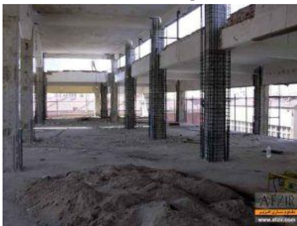
مقاوم سازی ستون بتنی به روش ژاکت بتنی
