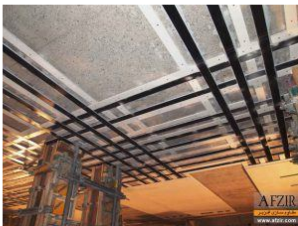
تقویت ظرفیت باربری دال بتنی با لمینیت کربن
